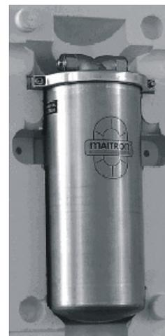
Zusammenfassend bleibt also festzuhalten, dass die Regelung nach derzeitiger Prüfung keine überspannungsbedingten Beschädigungen aufweist und der beschriebene Überspannungsschaden des Catalysators ggf. noch geprüft werden müsste. Beim VN müsste derzeit hilfsweise ein Rohrstück den defekten Catalysator ersetzen, damit überhaupt das Wasserzapfen im Hause möglich ist. Sollte der defekte Edelstahl-Catalysator noch montiert
